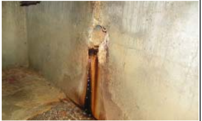
溢洪道排水廊道排水管情形
