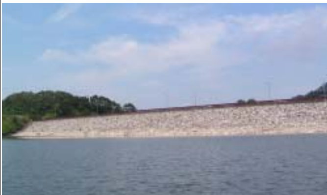
大壩上游坡面無明顯異常現象
