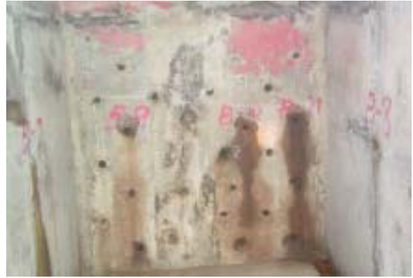
投池右岸邊坡排水廊道排水孔
