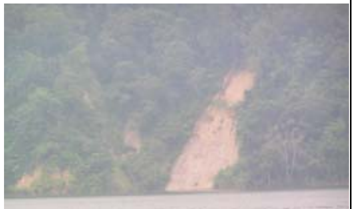
蓄水庫週邊右岸岩石裸露情形
