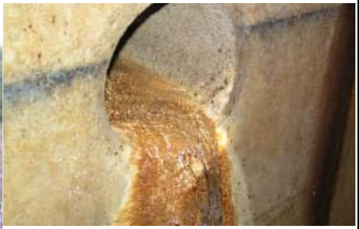
溢洪道排水廊道左側排水管排水情形
