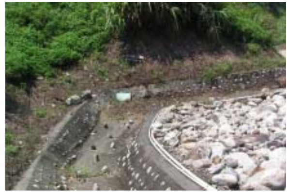
壩體與壩座交界處水溝無新增裂縫
