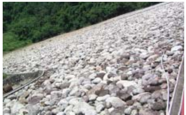
大壩上游坡面無明顯異常現象
