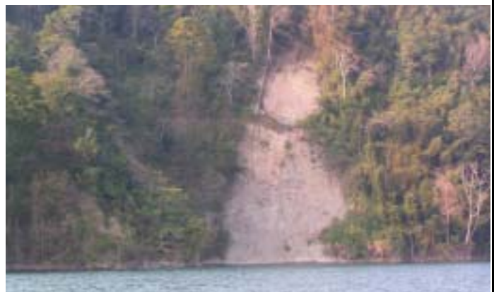
蓄水庫右岸邊坡岩石裸露情形
