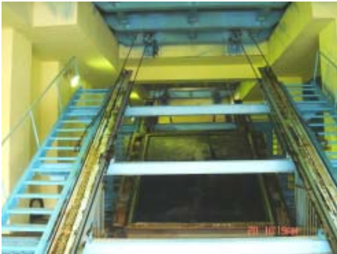
下層阻水閘門油漆普遍有老化現象
