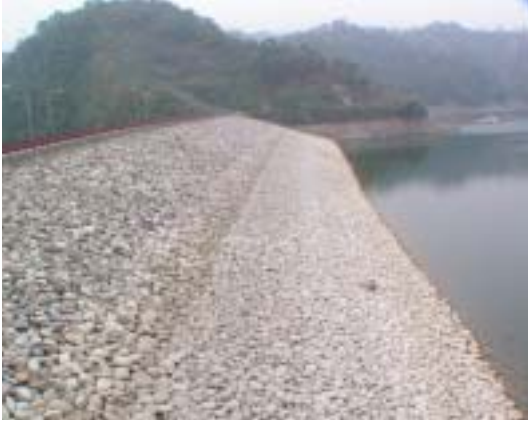
上游坡面臨水面顯示中心附近略為沉陷
