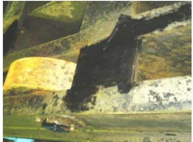
下層阻水閘門油漆普遍有老化現象
