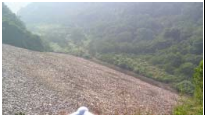
壩趾及下游壩面無異常凸起或滲水現象
