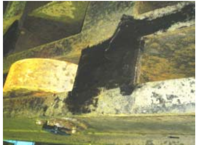
下層阻水閘門油漆普遍有老化現象
