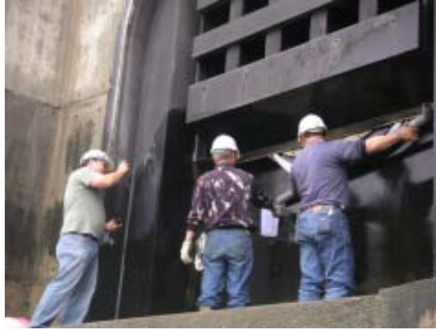
噴流閘門漏水用量杯接水情況
