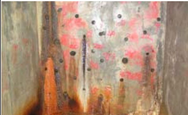
投池右岸排水廊道排水情形
