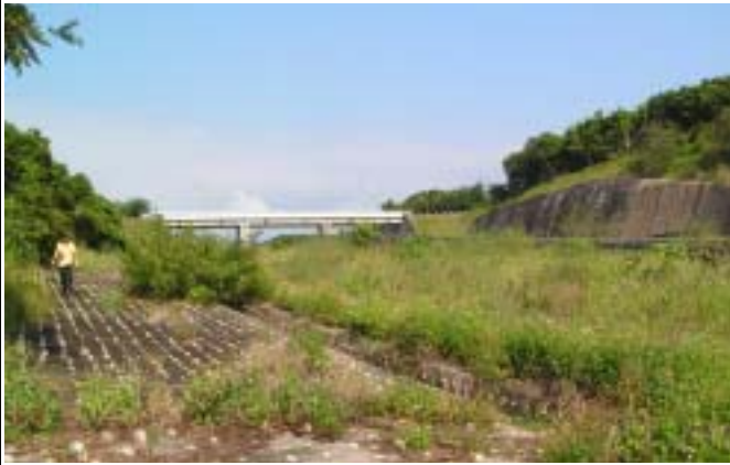
溢洪道右岸邊情形穩定
