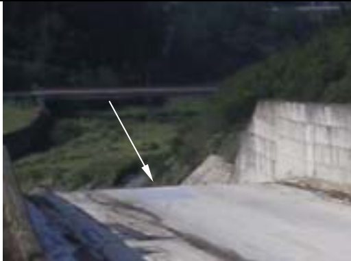
溢洪道補修情形
