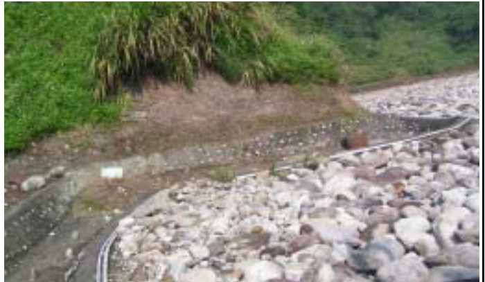
壩體與壩座交界處水溝無新增裂縫
