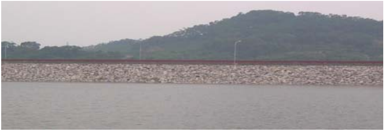
大壩上游坡面無明顯異常現象
