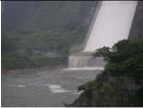
溢洪道洩洪情形
