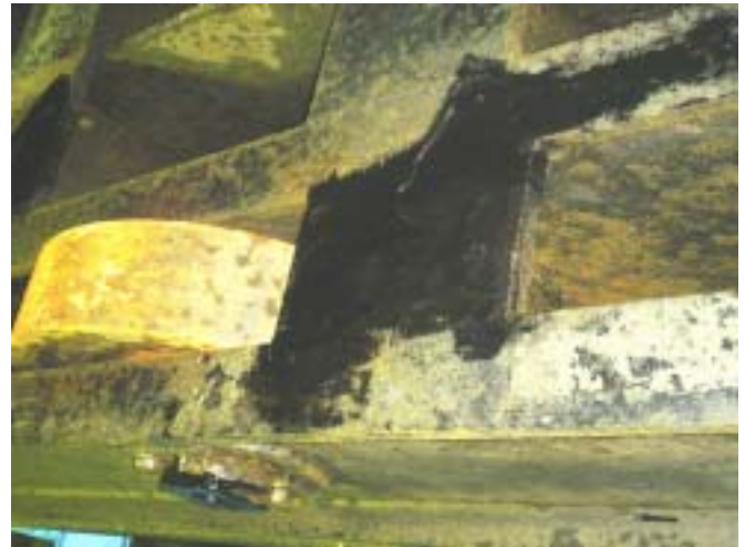
下層阻水閘門油漆普遍有老化現象
