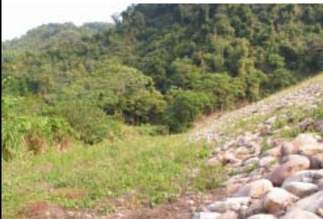
壩趾及下游壩面無異常凸起或滲水現象
