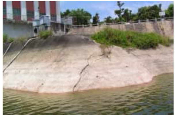
取水工右岸邊坡噴凝土大致完整
