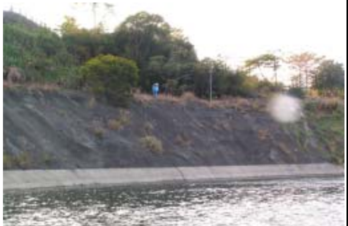
取水工左岸邊坡噴凝土大致完整
