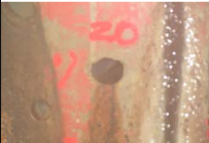
投池右岸排水廊道排水量較上一季減少
