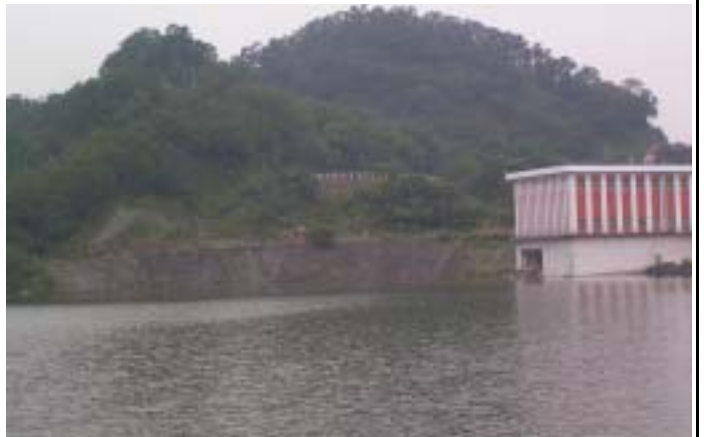
取水工左岸邊坡噴凝土大致完整
