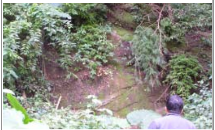
左壩座下游測無濕潤滲水現象
