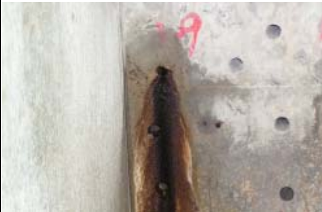
投池右岸排水廊道排水情形
