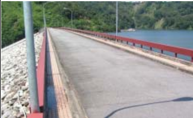
大壩壩頂道路完整
