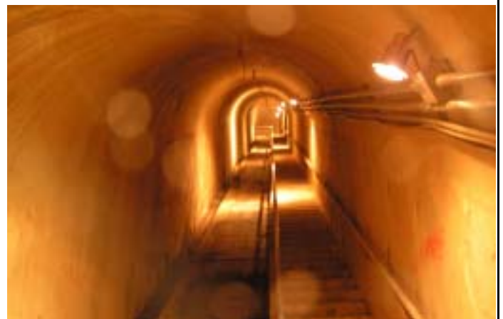
壩體廊道無異常現象
