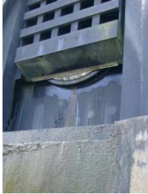
噴流閘門結構狀況正常
