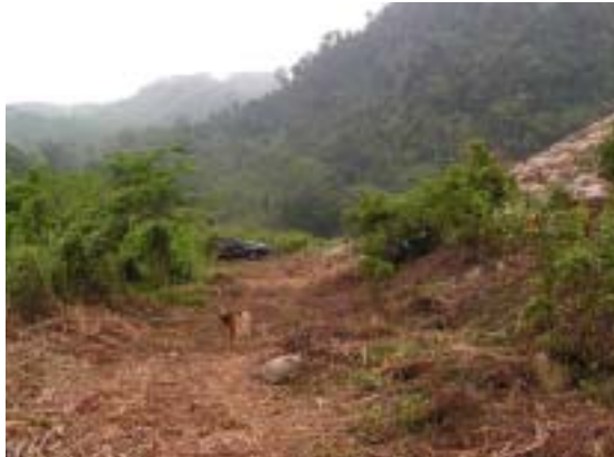
大壩壩趾地區無滲水及隆起現象
