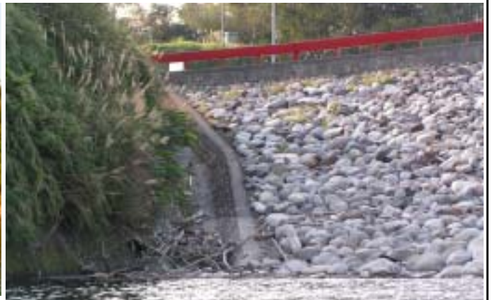
壩體與壩座交界處水溝無新增裂縫
