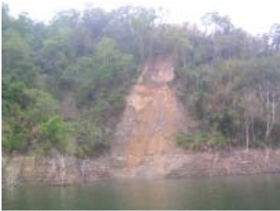
蓄水庫右岸邊坡局部滑動現象
