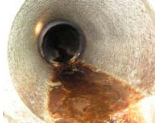
溢洪道排水廊道排氣孔無堵塞現象
